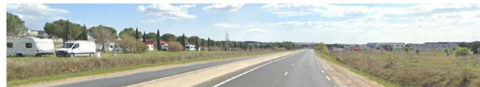
Vues de la D64 après le passage sous l'autoroute - en direction de Vendres (vue vers le sud)
