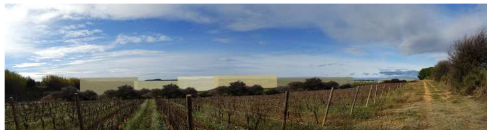
Vue depuis le sud-ouest
