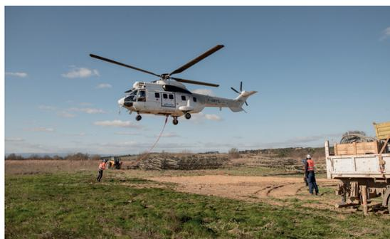
RTE a réalisé le démontage par hélicoptère de la ligne électrique à 63 000 volts reliant Nissan-Lez-Ensérune à Lunes, dont 16 pylônes situés sur le site Natura 2000 Collines d'Ensérune. Afin de réaliser les travaux en préservant la biodiversité des sites, RTE s'est associé à la Communauté de communes La Domitienne.
