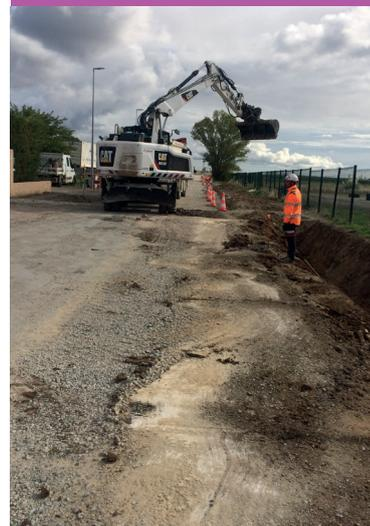
Une requalification en profondeur a démarré : démolition de la voirie existante, renouvellement de l'ensemble des réseaux humides (pluvial, branchements eau potable et Eaux Usées), reprise et création du réseau d'éclairage public, un maillage du réseau télécom existant a été fait en vue d'un déploiement de la fibre optique.
