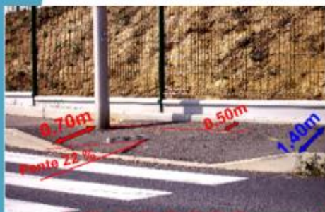
Candélabre mal positionné
